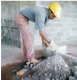
Separação de resíduos
