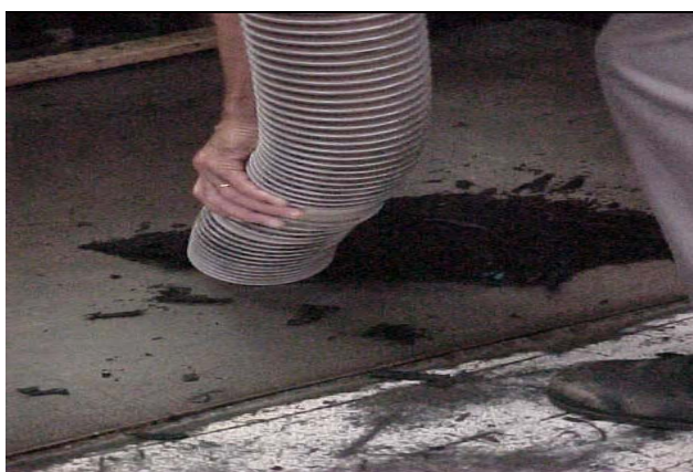
Figura 3.3 – Material sendo aspirado.
