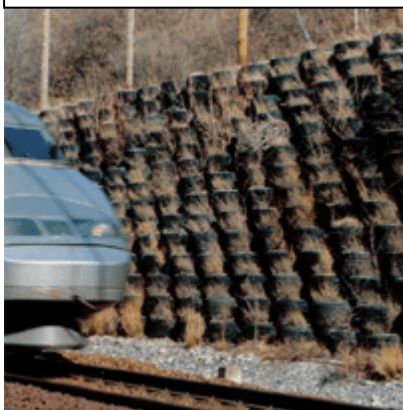
Figura 8: Barreira com pneus, construída pelo processo PNEUSOL [95]
