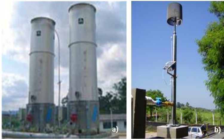
Figura - Flares. a) flare enclausurado (fechado); b) flare aberto. Fonte: ICLEI (2009); Combustec (2011).
