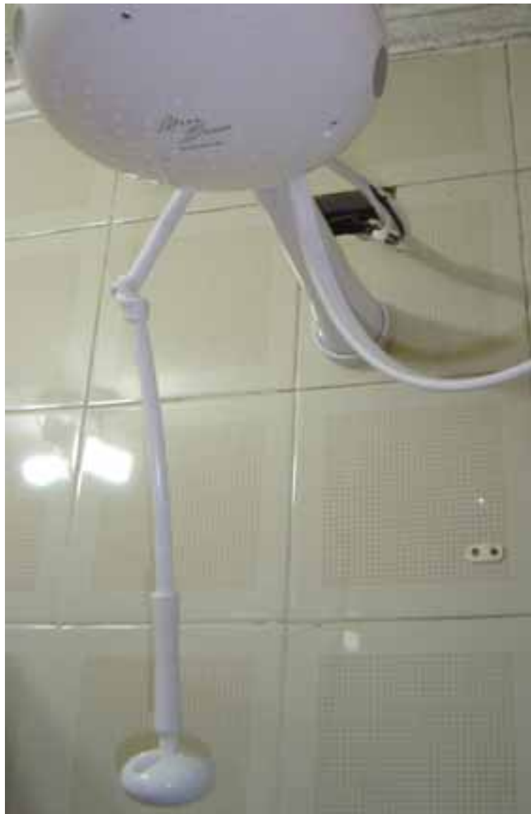
Fig. 37 – Quem não usa o “chuveirinho” muitas vezes é obrigado a fazer um nó em sua mangueira para evitar vazamentos e desperdício de água.
