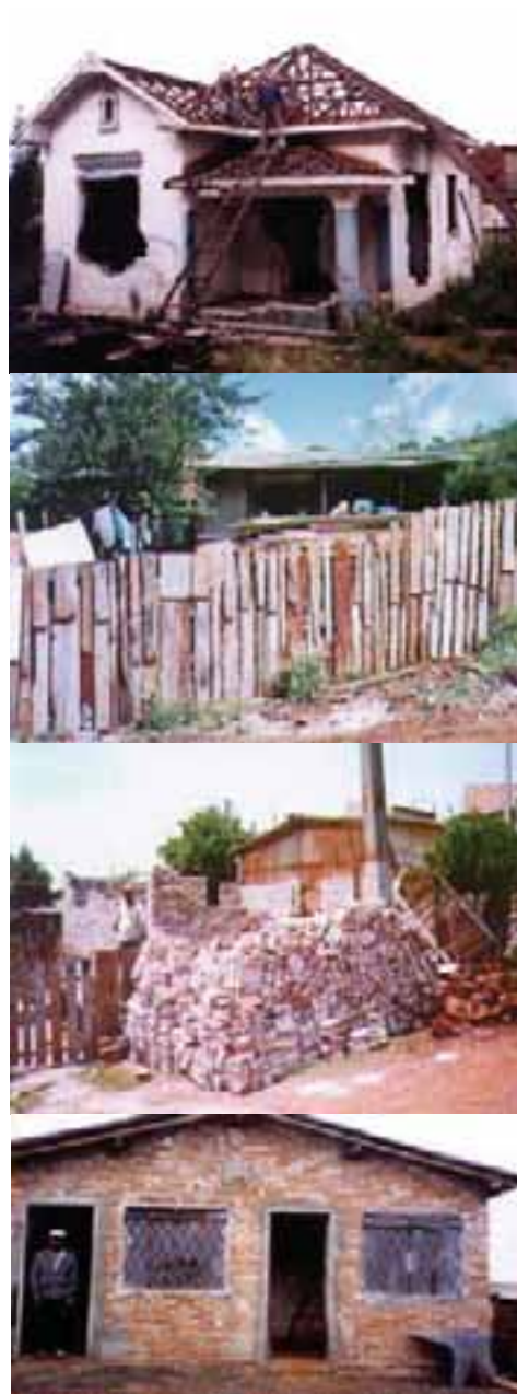
Fig. 52 – Na área de construção civil, o projeto Onde Moras de Londrina - PR (veja www.ondemoras.com.br ) utiliza material retirado de antigas casas e sistema de mutirão para a construção de novas moradias para famílias de baixa renda.
