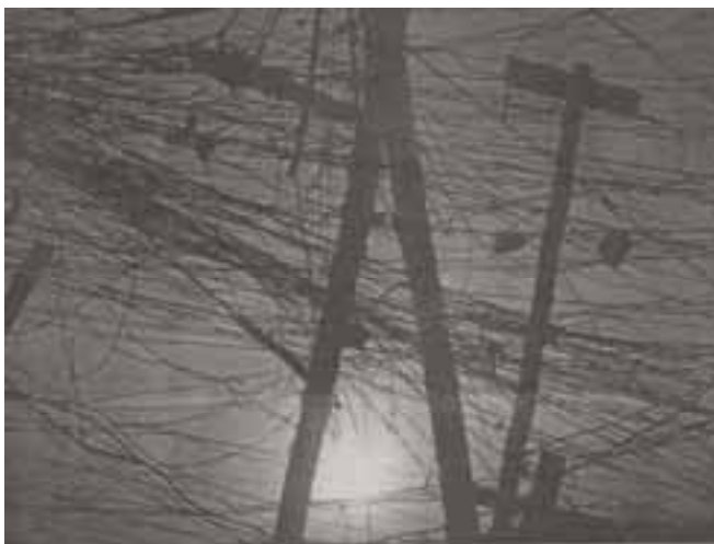
Fig. 03 – Conexões Irregulares de Eletricidade.
