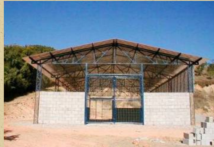
Exemplo de galpão com estrutura metálica
