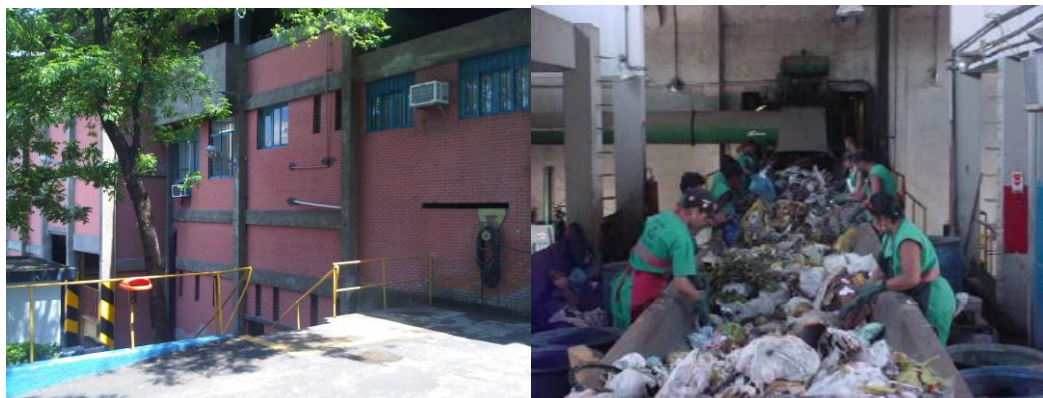
Figura 6.10 – Vista lateral da Usina de Reciclagem Luiz Eduardo Bahia – Rio de Janeiro – 2012. Foto Kátia campos Triagem na esteira rolante da Usina. Foto: COMLURB Rio de Janeiro – 2012
