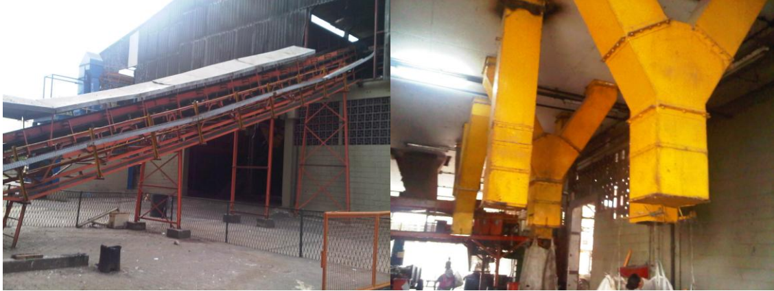
Figura 6.23– Esteira transportadora inclinada alimentadora da linha de produção e bicas de direcionamento dos resíduos do andar superior para a estocagem da IRR do Caju Foto: Kátia Campos Rio de Janeiro – 2012
