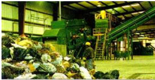
A. O lixo é removido da "área" de acumulação por uma pá carregadeira entrando no "Abridor de Sacos."
