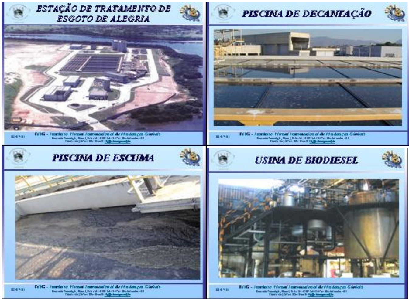
FIGURA 17 – ESTAÇÃO DE TRATAMENTO DE ESGOTO
