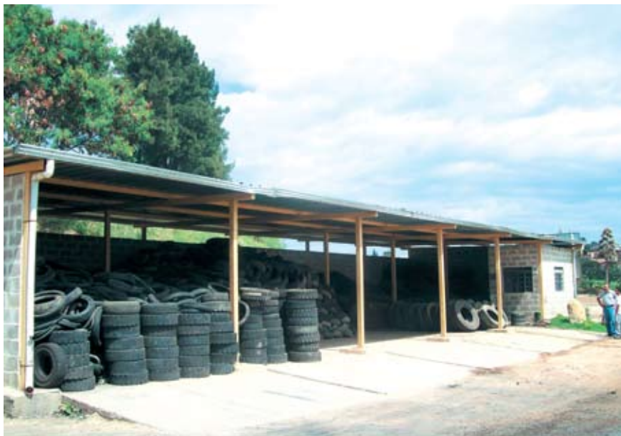
Unidade de Recebimento de Pneus – URP, em Belo Horizonte (MG)
