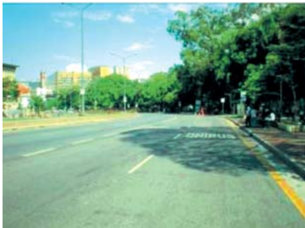
Trecho com pavimentado com asfalto borracha, em Belo Horizonte (MG)
