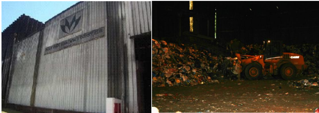
Figura 6.17 – Fachada frontal da IRR Ceilândia. Foto: PDRS DF. Área de recepção dos resíduos e alimentação as linhas de produção da IRR Ceilândia – Brasília – 2012. Foto: Kátia Campos.
