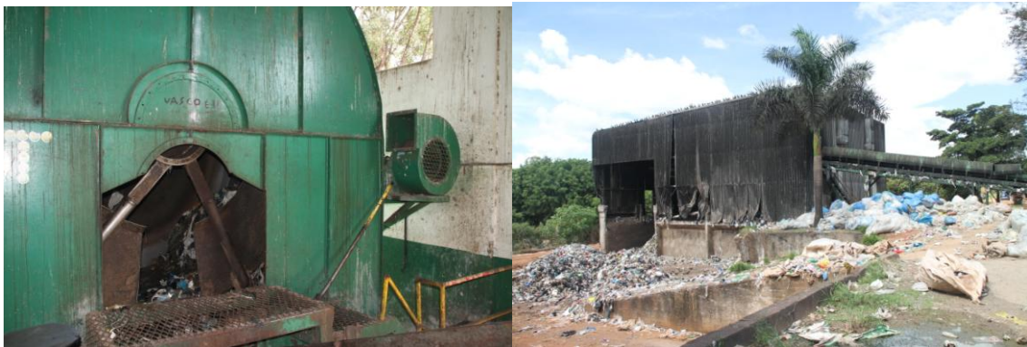
Figura 6.15 – Saída do biorreator e galpão para armazenamento de estoque de rejeitos para encaminhamento ao lixão da Estrutural - IRR Asa Sul Fotos: Kátia Campos Brasília – 2012
