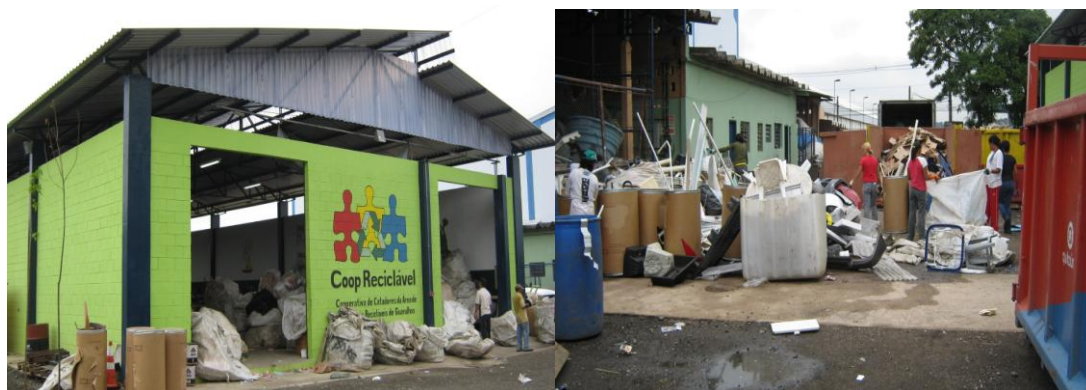
Figura 6.5 – Vista frontal e lateral da IRR COOP RECICLÁVEL Fotos: Kátia Campos Guarulhos - 2012
