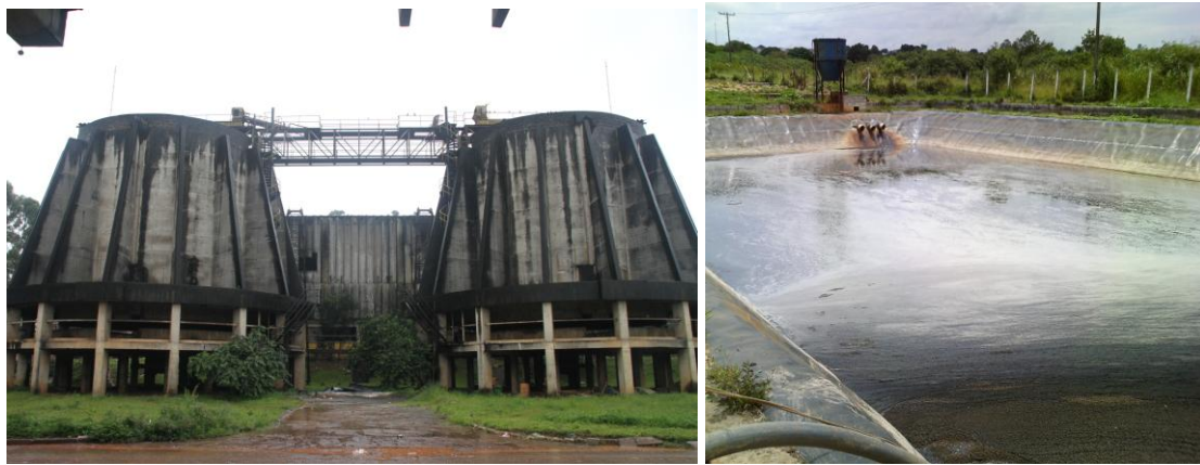
Figura 6.21 – Biorreatores para aceleração do processo de decomposição anaeróbica inativado e lagoa de tratamento de chorume do processo de compostagem da IRR Ceilândia Fotos: Kátia Campos Brasília – 2012
