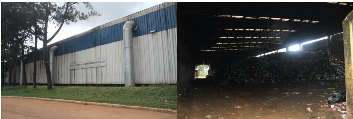
Figura 6.12 – Vista frontal e do pátio de recebimento de resíduos da IRR Asa Sul – área de recepção de resíduos Fotos: Kátia Campos Brasília - 2012
