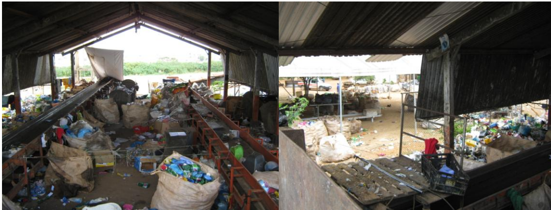
Figura 6.7 – Vista interna e lateral da IRR de Brazlândia Foto: Kátia Campos Distrito Federal – 2012
