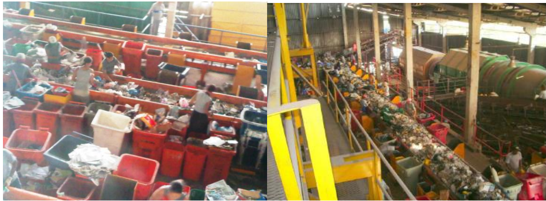
Figura 6.24 – Catação manual na esteira rolante e containers para estoque de materiais recicláveis Foto: Kátia Campos Área lateral da IRR com catação manual em esteira rolante e peneiras rotativas da IRR do Caju Foto: COMLURB Rio de Janeiro - 2012
