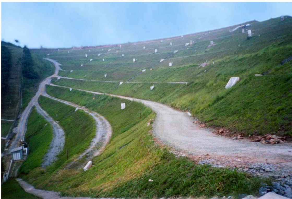
FIGURA 18 – Drenos do Aterro Municipal de Santo André
