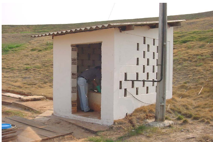
Figura 4-8: Poço de concentração, recalque e recirculação de chorume do aterro de Bauru.
